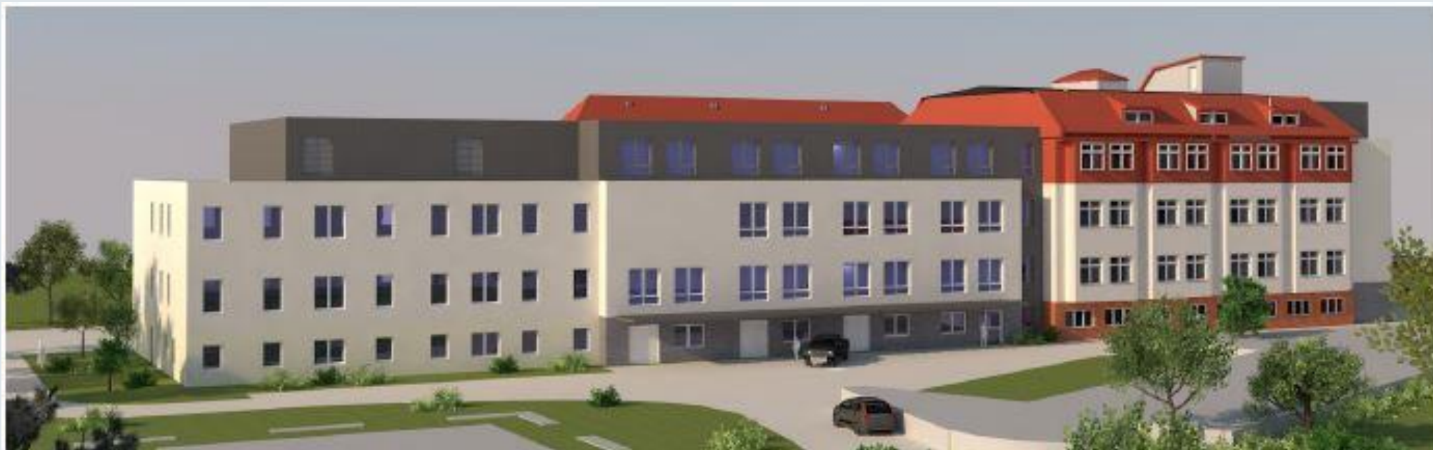
2. Bauabschnitt | Blick aus Nord-Osten auf OP-Trakt und erweiterten Stationstrakt
