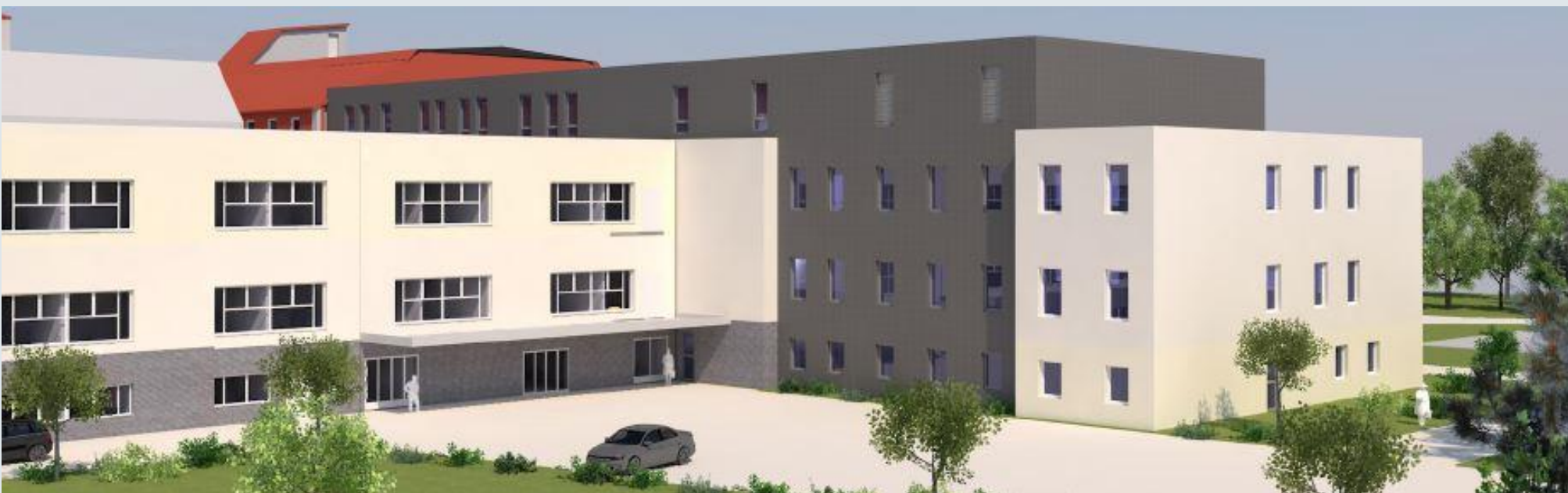
2. Bauabschnitt | Blick von Süd-Osten auf OP-Trakt und Liegend-Einfahrt
